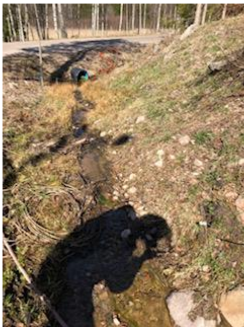
Trumma 76 uppströms (markerad som 5 i bild) sett från trumma 77.
