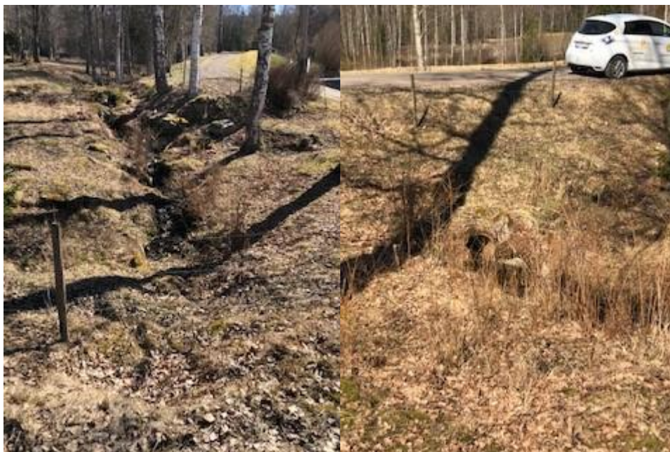
Trumma 25 uppströms och bäckens utseende uppströms.
