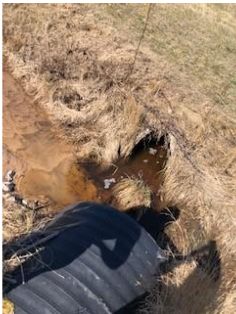
Exempel på bra trumma uppströms ovanifrån.
