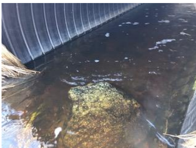
Exempel på bra trumma uppströms.
