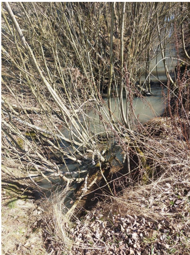
Östra Alstern. Trumma 70 uppströms. Inlopp ej synligt.
