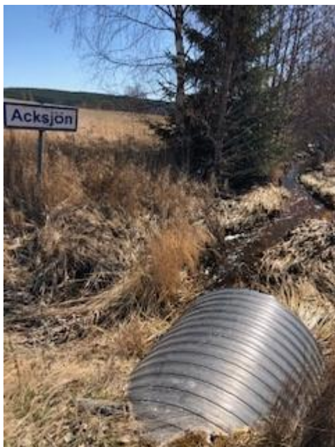
Exempel på bra trumma nedströms ovanifrån.
