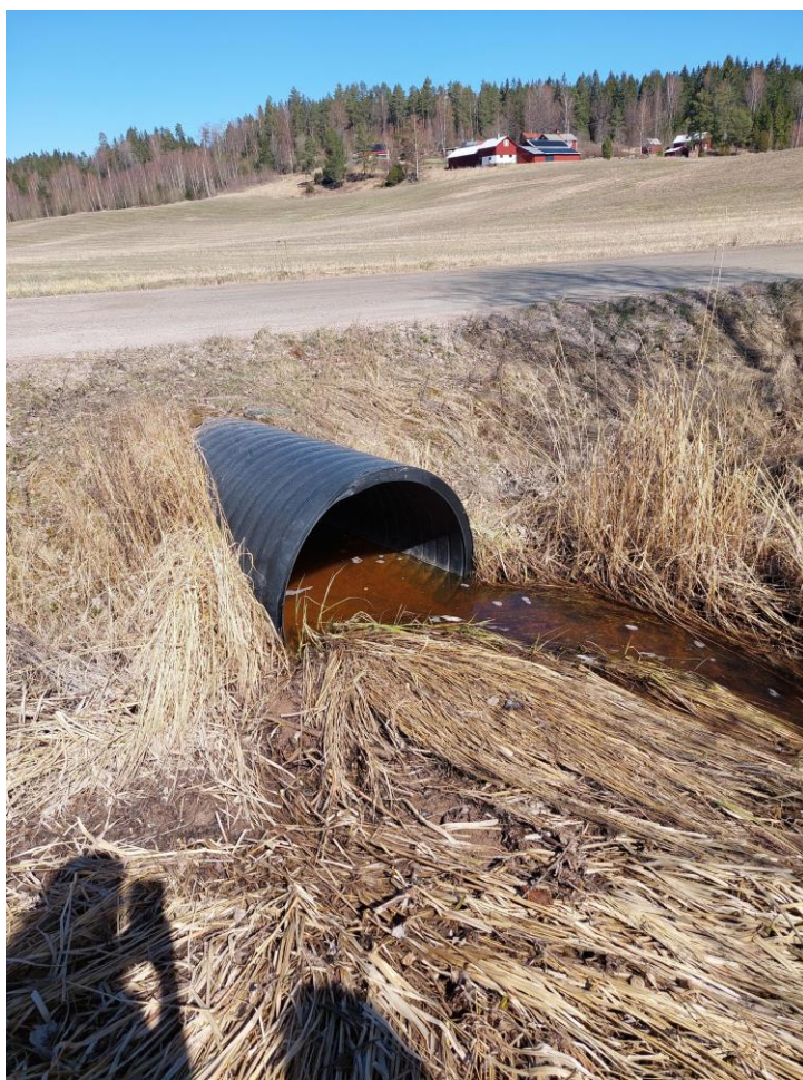
Exempel på bra trumma nedströms.
