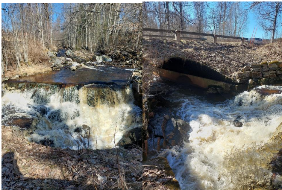
Trumma 27, uppströms. Stenbro med naturlig bergvägg uppströms.
