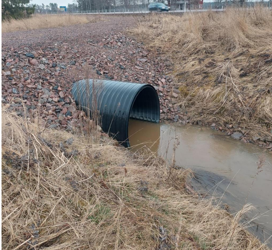
Bild 2: Nybyggd heltrumma i plast. Placerad mellan trummorna nr 49 och 50.
