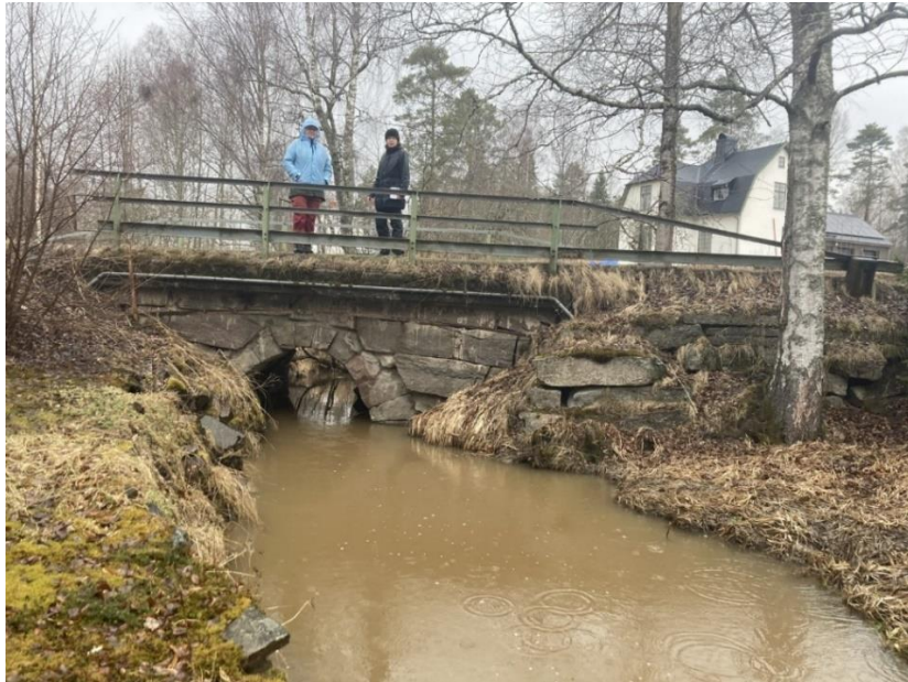
Bild 10: Vägtrumma nr 47, stenvalvsbro.
