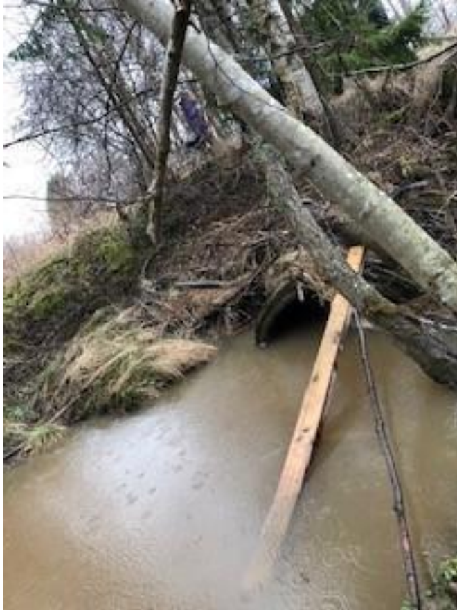
Bild 4: Vägtrumma nr 49, knäckt.
