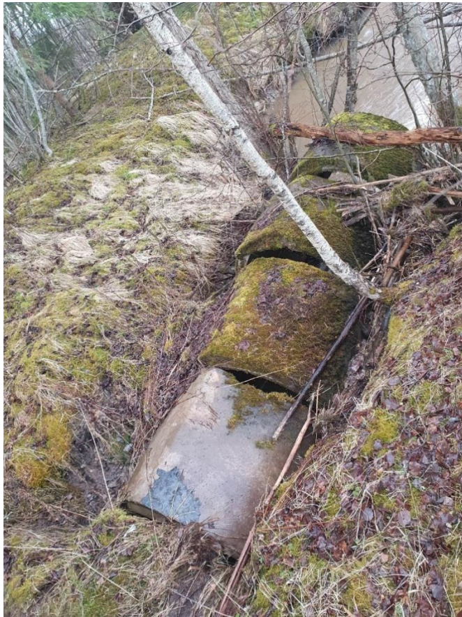
Bild 6: Vägtrumma nr 48. Knäckt.
