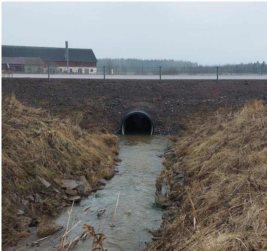
Bild 3: Trumma nr 50. Nybyggd heltrumma i plast under väg 63.
